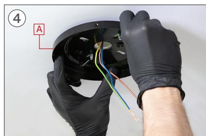
4 Coloque a peça A combinando seus orifícios com os parafusos D. Certifique-se de que os cabos do teto passam pelo orifício central da peça A.
