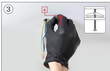
Insira os parafusos de fixação nos orifícios e certifique-se de que a alavanca abre.
