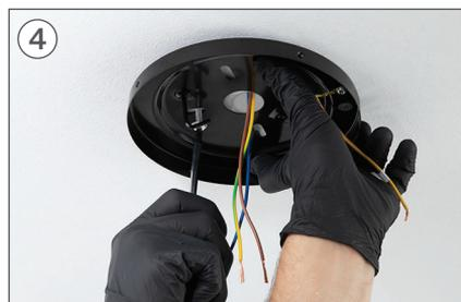
Coloque a peça A e aparafusar os parafusos de fixação ao tecto falso.
