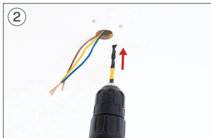
2 Se necessário, dependendo do tipo de telhado, será necessário usar uma furadeira para fazer o furo na madeira.
