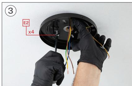
3 Coloque a arruela e depois o parafuso D2 com a ajuda da chave de fenda.
