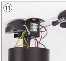
11 Conecte o fio N do driver ao fio NEUTRO de sua instalação.
