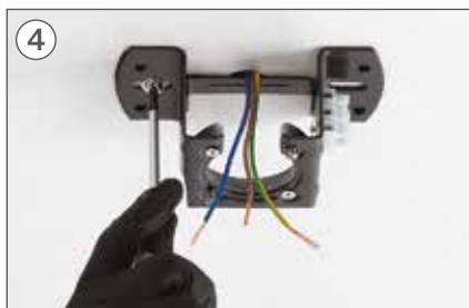
Coloque a peça K e aparafuse os parafusos de fixação ao tecto falso.
