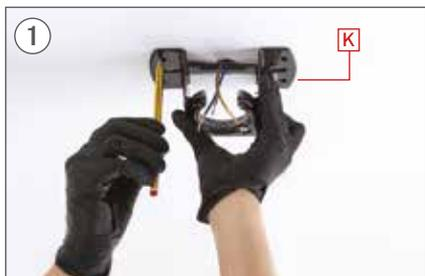
Marque no teto com um lápis os 2 orifícios centrais da peça K usando a peça é um guia.
