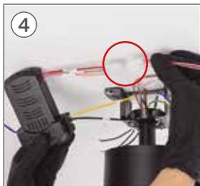
4 Junte-se às conexões de parte B com as conexões do motor, cada uma com sua cor correspondente.
