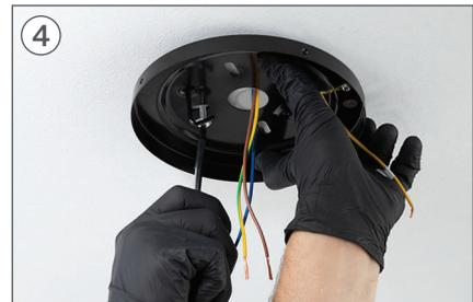
4 Coloque a peça H e aparafuse os parafusos de fixação ao tecto falso.
