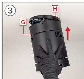
Tire a peça **G** do gancho e encaixe-o na peça **H** sem prender nenhum fio.
