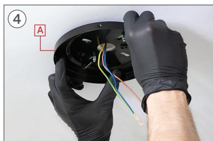
Coloque a peça H combinando seus orifícios com os parafusos I. Certifique-se de que os cabos do teto passem pelo orifício central da peça H.
