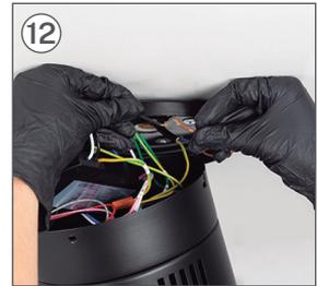
Conecte o cabo PHASE do driver (AC-L) ao cabo PHASE da sua instalação.
