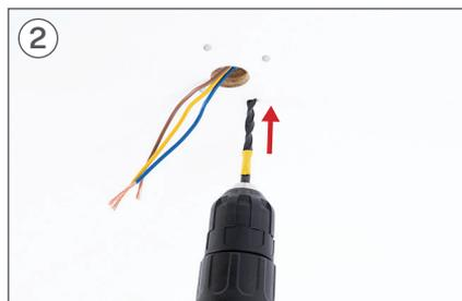
2 Se necessário, dependendo do tipo de telhado, será necessário usar uma furadeira para fazer o furo na madeira.
