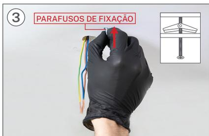
3 Insira os parafusos de ajuste nos orifícios e verifique se a alavanca abre.
