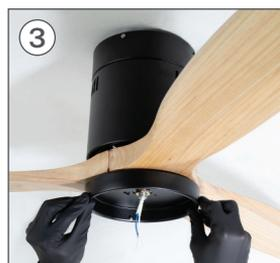
Para colocar a peça H Passe os fios do ventilador pelo orifício central, igualando os 2 orifícios com os do suporte central.
