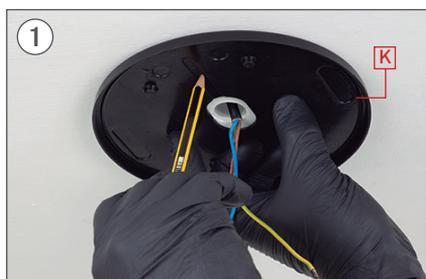
1 Marcar 2 furos paralelos com um lápis, utilizando a peça K como guia.
