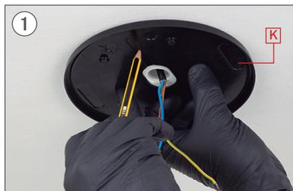
1 Marcar 2 furos paralelos com um lápis, utilizando a peça K como guia.
