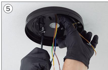
5 Posicionar o conjunto A-K e aparafusar os parafusos de fixação ao teto falso.
