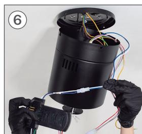
Junte as conexões da peça I com os da peça B, cada um com sua cor correspondente.
