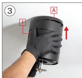
Retire a peça do gancho I e encaixar na peça A sem prender nenhum fio.
