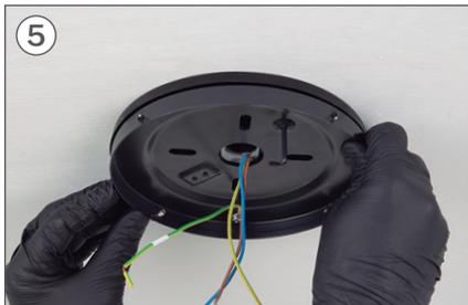
Colocar o conjunto no teto, fazendo coincidir os seus orifícios com os dos parafusos, deixando os fios salientes no orifício central.
