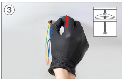
3 Introduzir os parafusos de fixação nos furos e certificar-se de que a alavanca abre.
