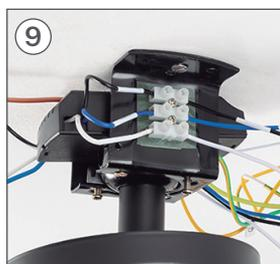
Com a ajuda de uma chave de fenda, conecte os fios restantes da peça B aos do ventilador, unindo cada um com a tira e seu respectivo cabo.
