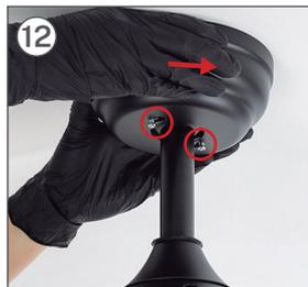
Assim que os cabos estiverem conectados, deslize a peça A até encaixar os parafusos que se projetam da peça K. Assim que estiverem encaixados, vire a peça A para a direita.
