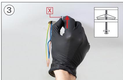
3 Insira os parafusos de ajuste nos orifícios e verifique se a alavanca abre.
