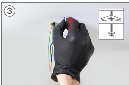
3 Insira os parafusos de fixação nos orifícios e certifique-se de que a alavanca abre.
