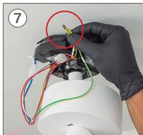
Selecione e conecte todos os fios de aterramento, incluindo o da sua instalação.
