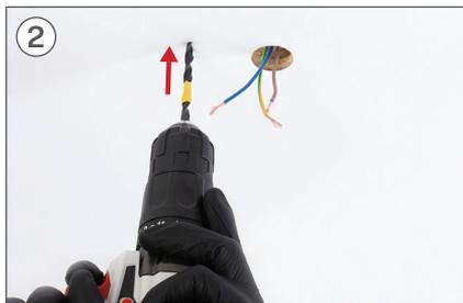
Se necessário, dependendo do tipo de telhado, será necessário usar uma furadeira para fazer o furo na madeira.
