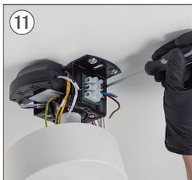
11 Conecte o cabo N do driver ao cabo NEUTRO da sua instalação.
