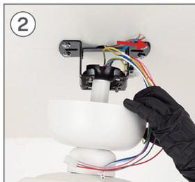
Lembre-se de ajustar o entalhe no suporte de inclinação para trás para que a peça se encaixe perfeitamente.
