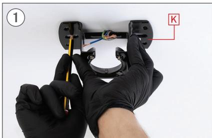
Marque no teto com um lápis os 2 orifícios centrais da peça K usando a peça K como guia.
