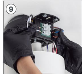
Você precisará agrupar os fios restantes na peça **B** e os cabos de fase e neutro de sua instalação no bloco de terminais da peça **K**, conforme mostrado a seguir.
