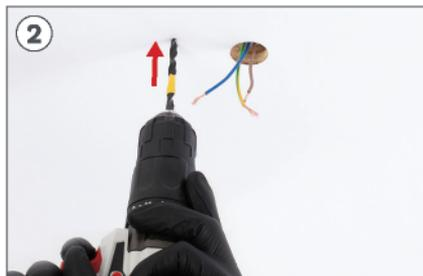
Se necessário, dependendo do tipo de telhado, será necessário usar uma furadeira para fazer o furo na madeira.
