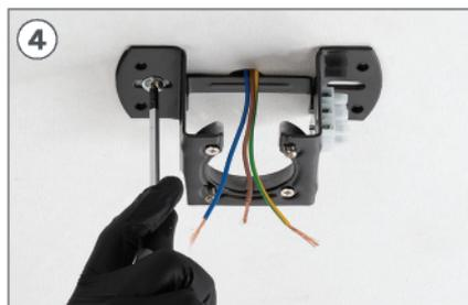
4 Coloque a peça K e aparafuse os parafusos de fixação ao tecto falso.
