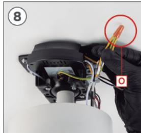
Uma vez conectado, coloque a peça **O** aparafusando-o até que fique bem preso.
