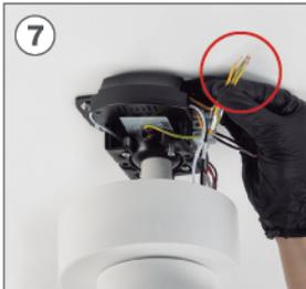
Selecione e conecte todos os fios de aterramento, incluindo aquele para sua instalação.
