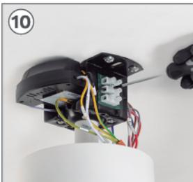
Conecte o cabo L do driver ao cabo PHASE de sua instalação.
