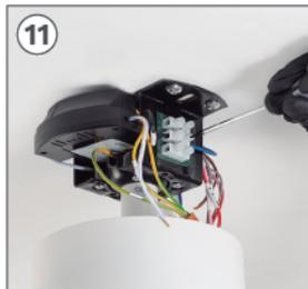
Conecte o fio N do driver ao fio NEUTRO de sua instalação.
