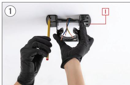
Marque no teto com um lápis os 2 orifícios centrais da peça I usando a peça I como guia.
