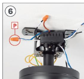
Conecte o cabo FASE (L) de sua instalação ao cabo FASE da peça **B**. Uma vez conectado, coloque a peça **P** aparafusando-o até que fique bem preso.
