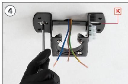
Coloque a peça K e aparafuse os parafusos de fixação ao tecto falso.
