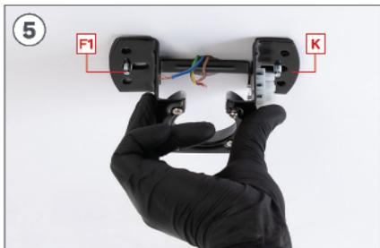
Coloque a peça **K** combinando seus orifícios com os parafusos **F1**. Certifique-se de que os cabos do teto estejam de um lado da peça **K**.
