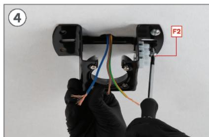
4 Usando a chave de fenda, aperte os parafusos F2.
