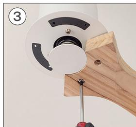
Coloque a primeira lâmina C fixando-o com as arruelas e os parafusos H com a ajuda da chave de fenda, sem apertar muito, para poder colocar o resto.
