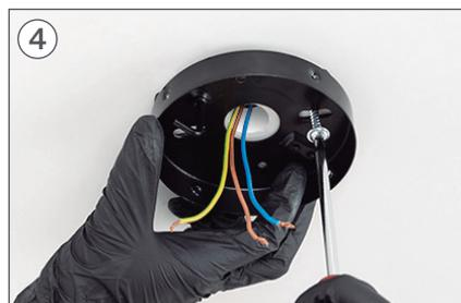
4 Coloque a peça A e aparafuse os parafusos de fixação ao tecto falso.
