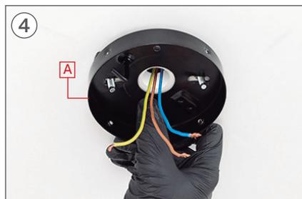
4 Coloque a peça A combinando seus furos com os parafusos D. Certifique-se de que os cabos do teto passem pelo orifício central da peça A.
