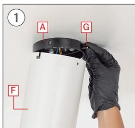
Use 2 parafusos **G** e aparafuse-os, sem apertar muito, nos furos paralelos da peça **A**.
