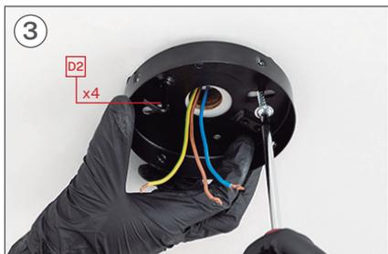
Coloque a arruela e depois o parafuso D2 com a ajuda da chave de fenda.
