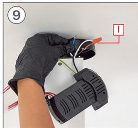
9 Conecte o cabo NEUTRO do driver (AC-N) ao cabo NEUTRO da sua instalação.
