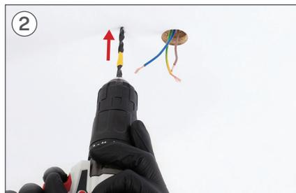
Se necessário, dependendo do tipo de telhado, você precisará usar uma furadeira para fazer o furo na madeira.
