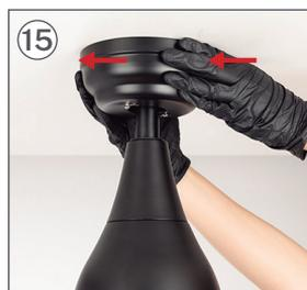
15 Depois de encaixado, vire a peça A para a esquerda. Certifique-se de que nenhum fio fique preso.
