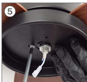
Deixe os fios azul e branco saindo do orifício e aperte firmemente os parafusos usados na etapa 1 para que a peça G está devidamente fixado.
