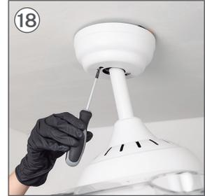
Com o auxílio de uma chave de fenda, aperte os parafusos do lado esquerdo.
