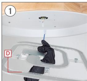
Conecte os fios da peça D. aos do ventilador que une as conexões.
