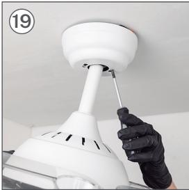
Por fim, com o auxílio de uma chave de fenda, aperte os parafusos do lado direito.
