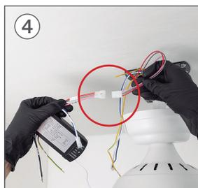
Junte as conexões da peça B. com as ligações do motor, cada um com sua cor correspondente.
