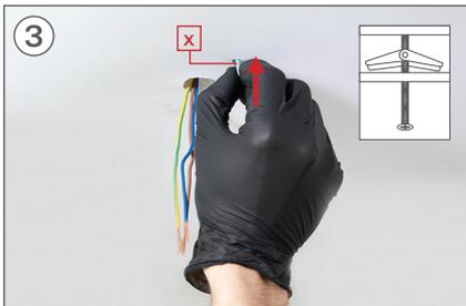
Insira os parafusos de fixação nos orifícios e certifique-se de que a alavanca abre.
