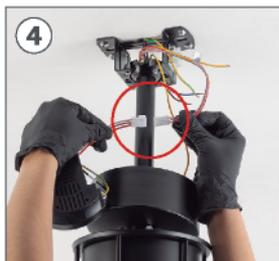
Junte-se às conexões de parte B com as conexões do motor, cada uma com sua cor correspondente.
