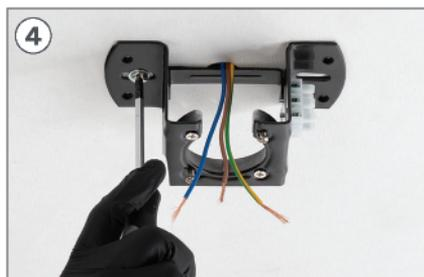
4 Coloque a peça I e aparafuse os parafusos de fixação ao tecto falso.
