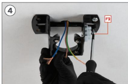
Usando a chave de fenda, aperte o parafuso F2.
