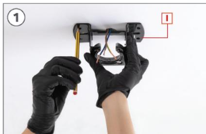
1 Marque no teto com um lápis os 2 orifícios centrais da peça I usando a peça é um guia.
