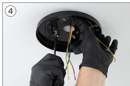
Posizionare il pezzo A ed avvitare le viti di fissaggio al controsoffitto.
