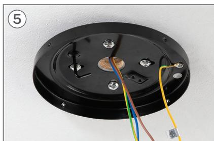
Assicurati la parte A Si fissa perfettamente al soffitto con le viti ben serrate.
