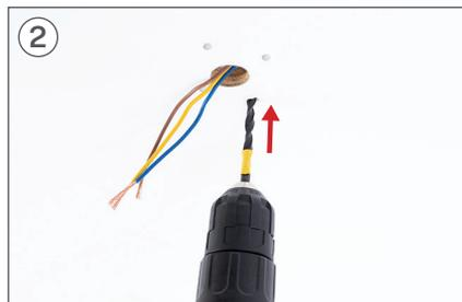
Se necessario, a seconda del tipo di tetto, sarà necessario utilizzare un trapano per praticare il foro nel legno.
