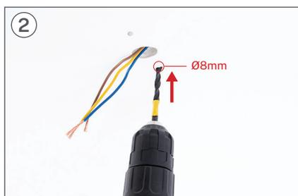
2 Con l'ausilio di un trapano praticare i due fori corrispondenti con una punta Ø8 mm.
