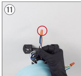
Collegare il filo NEUTRO (N) della propria installazione al filo NEUTRO. Una volta connesso, posiziona la parte M avvitandolo fino a quando non è ben fissato.
