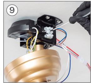
Collega il cavo L del driver al cavo PHASE della tua installazione.
