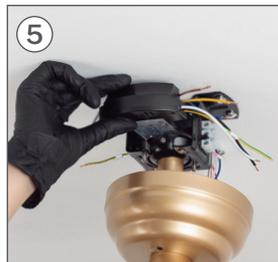
5 Una volta collegati i cavi, inserire la parte B all'interno del pezzo L, come mostrato in figura.
