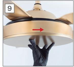
Allora prendi la parte **Q** e avviti le viti **R** sul dado **S** precedentemente posizionato sul ventilatore. Una volta che la parte è a posto, puoi collegare l'elettricità e goderti il tuo nuovo ventilatore.
