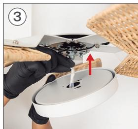
Passare i cavi del motore attraverso il foro centrale della parte L.
