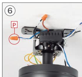
Collega il cavo PHASE (L) della tua installazione al cavo PHASE della parte **B**. Una volta connesso, posizionare la parte **P** avvitandolo finché non è ben fissato.
