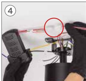
Unisci le connessioni di parte **B** con i collegamenti del motore, ciascuno con il colore corrispondente.
