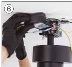
Una volta collegati i cavi, inserire la parte **B** all'interno del pezzo **K**, come mostrato in figura.
