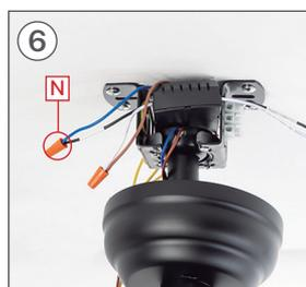
Collega il filo FASE (L) della tua installazione al filo FASE della parte **B**. Una volta connesso, posiziona la parte **N** avvitandolo fino a quando non è sicuro.
