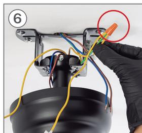
Collegare il filo di terra della parte H quella del motore. Inoltre, se l'installazione elettrica è costituita dal proprio cavo di messa a terra, collegarlo anche ai cavi della parte H e il motore.
