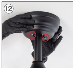
Una volta collegati i cavi, far scorrere la parte A fino ad incastrare le viti sporgenti dal pezzo J. Una volta montato, gira il pezzo A a destra.
