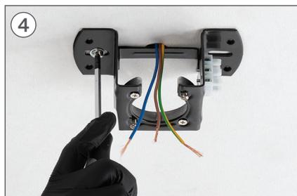
Posiziona la parte K e avvita le viti di fissaggio al controsoffitto.
