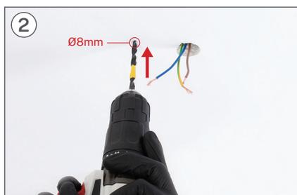
Con l'ausilio di un trapano praticare i due fori corrispondenti con una punta Ø8 mm.
