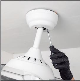
Infine, con l'aiuto di un cacciavite, serrare le viti sul lato destro.
