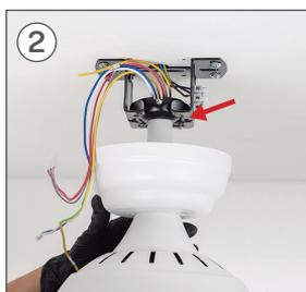
2 Ricordarsi di posizionare la tacca sulla staffa di inclinazione verso la parte posteriore in modo che la parte si adatti correttamente.
