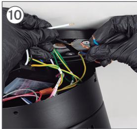
10 Collegare il cavo NEUTRO (N) del driver al cavo NEUTRO (N) della propria installazione.
