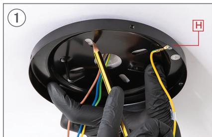
1 Segna sul soffitto con una matita 2 fori paralleli usando il pezzo H come una guida.
