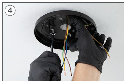
4 Posiziona la parte H e avvita le viti di fissaggio al controsoffitto.
