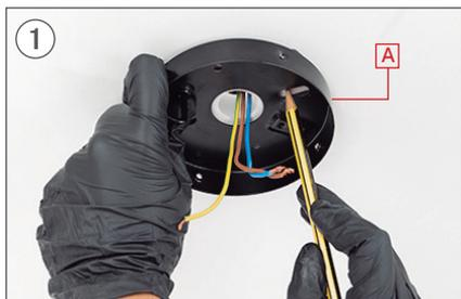
Segna sul soffitto con una matita 2 fori paralleli usando il pezzo A come una guida.
