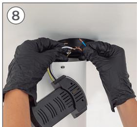
Collega il cavo PHASE del driver (AC-L) al cavo PHASE della tua installazione. Una volta connesso, posizionare la parte I.
