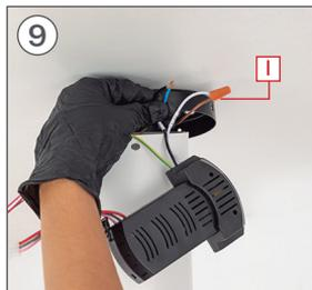
Collegare il cavo NEUTRO del driver (AC-N) al cavo NEUTRO della propria installazione.
