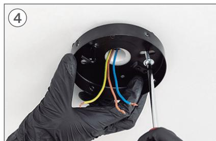
Posizionare il pezzo A e avvitare le viti di fissaggio al controsoffitto.
