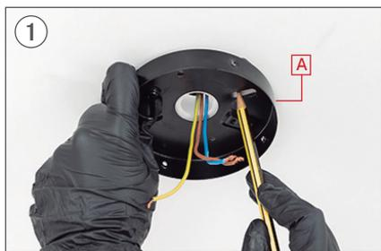
1 Segna con una matita 2 fori paralleli usando la parte A come una guida.
