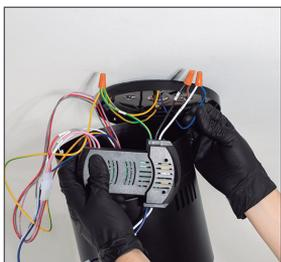
Collegare il cavo NEUTRO del driver (AC-L) al cavo NEUTRO del proprio impianto. Una volta connesso, posizionare il pezzo **M**.
