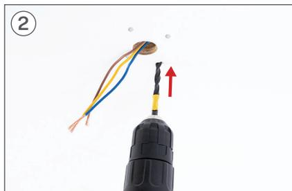
Se necessario, a seconda del tipo di tetto, sarà necessario utilizzare un trapano per praticare il foro nel legno.
