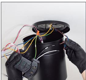
Collegare il cavo FASE del driver (AC-N) al cavo FASE della propria installazione.
