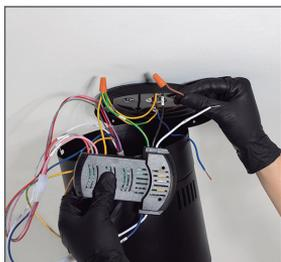
Una volta connesso, posizionare il pezzo **M** avvitandolo finché non è sicuro.
