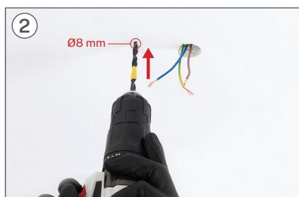
2 Con l'aiuto di un trapano, eseguire i due fori corrispondenti con una punta da trapano  $\varnothing 8$  mm.
