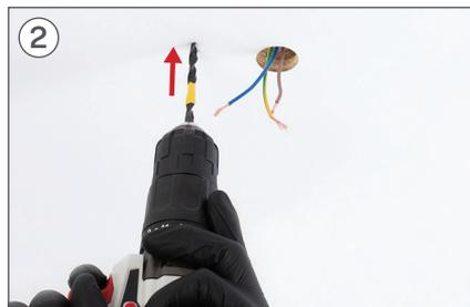
2 Se necessario, a seconda del tipo di tetto, sarà necessario utilizzare un trapano per praticare il foro nel legno.
