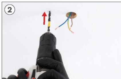
2 Se necessario, a seconda del tipo di tetto, sarà necessario utilizzare un trapano per praticare il foro nel legno.
