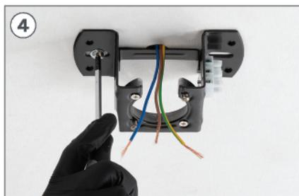
Posiziona la parte K e avvitare le viti di fissaggio al controsoffitto.
