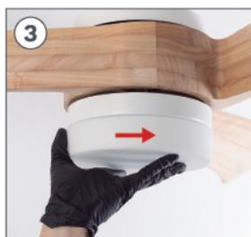
Posiziona la parte **F** sul ventilatore inserendolo nel motore e fissandolo ruotandolo in senso orario. Non dimenticare di controllare che la parte **F** calza bene. Una volta verificato, sarai in grado di collegare l'elettricità e goderti il tuo nuovo ventilatore con la luce.
