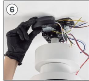
Una volta collegati i cavi, inserire la parte **B** all'interno del pezzo **K**, Come mostrato in figura.
