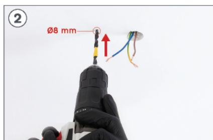
A l'aide d'une perceuse, réalisez les deux trous correspondants avec un foret  $\varnothing 8 \text{ mm}$ .
