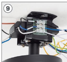
A l'aide d'un tournevis plat, connectez les fils restants de la pièce **B** à ceux du ventilateur, en joignant chacun avec la bande et son câble respectif.
