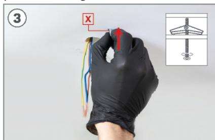
Insérez les vis de fixation dans les trous et assurez-vous que le levier s'ouvre.
