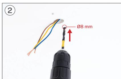
2 À l'aide d'une perceuse, percez les deux trous correspondants avec une mèche de Ø8 mm.
