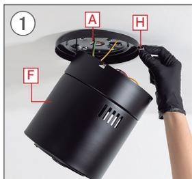
Utilisez 2 vis H et vissez-les sans serrer dans les trous parallèles de la pièce A.
