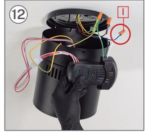
12 Connectez le câble PHASE du driver (AC-L) au câble PHASE de votre installation. Une fois connecté, placez la pièce I.
