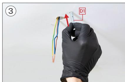
3 Insérez les morceaux D1 dans les trous du plafond.
