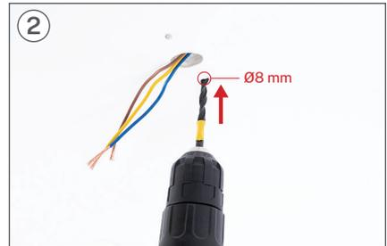
A l'aide d'une perceuse, percer les deux trous correspondants avec une mèche de Ø8 mm.
