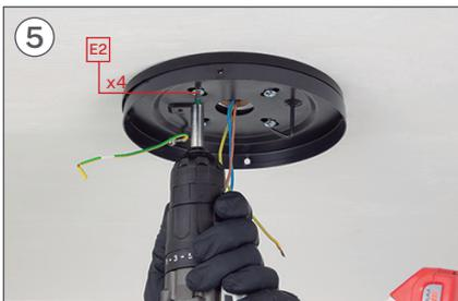
Mettez en place les rondelles puis les vis E2 à l'aide de la perceuse pour fixer l'ensemble au plafond.
