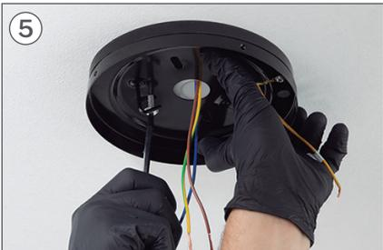
5 Positionnez l'ensemble A-K et vissez les vis de fixation au faux plafond.
