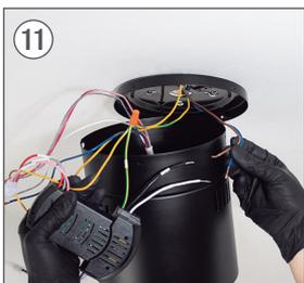
Connectez le câble PHASE du driver (AC-N) au câble NEUTRE de votre installation.
