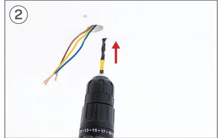
2 A l'aide d'une perceuse, percer les deux trous correspondants.
