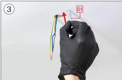
Insérer les pièces D1 dans les trous du plafond.
