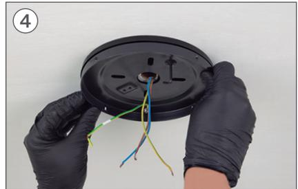
Positionner l'ensemble sur le plafond avec les câbles dépassant du centre.
