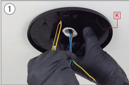
Tracer deux trous parallèles à l'aide d'un crayon en utilisant la pièce K comme guide.
