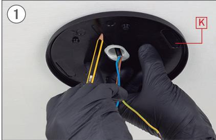
1 Tracer deux trous parallèles à l'aide d'un crayon en utilisant la pièce K comme guide.
