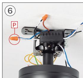
Connectez le câble PHASE (L) de votre installation au câble PHASE de la pièce B. Une fois connecté, placez la pièce P en le vissant jusqu'à ce qu'il soit bien fixé.
