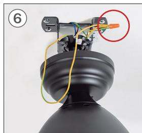
Connectez le fil de terre partiel I celui du moteur. De plus, si votre installation électrique est constituée de votre propre câble de mise à la terre, connectez-le également aux câbles de la pièce I et le moteur.
