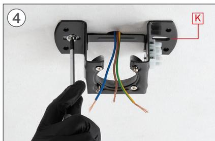
Placer la pièce K et vissez les vis de fixation au faux plafond.
