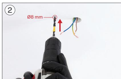
A l'aide d'une perceuse, réalisez les deux trous correspondants avec un foret Ø8 mm.
