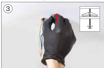
Insérez les vis de fixation dans les trous et assurez-vous que le levier s'ouvre.
