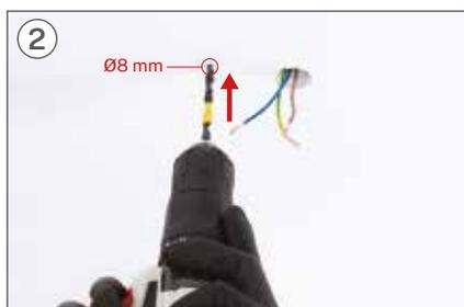
A l'aide d'un foret, réalisez les deux trous correspondants avec un foret de Ø8 mm.
