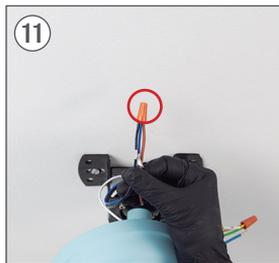
Connectez le fil de Phase (F) avec le fil noir (moteur) et le fil bleu (lampe). Une fois connecté, placez la pièce M en le vissant jusqu'à ce qu'il soit bien fixé.
