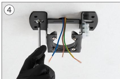
Placer la pièce K et vissez les vis de fixation sur le faux plafond.
