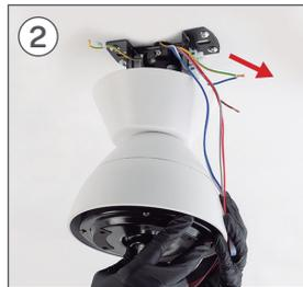
N'oubliez pas de positionner l'encoche dans le support d'inclinaison vers l'arrière afin que la pièce s'ajuste correctement.
