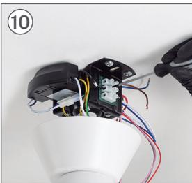
Connectez le câble L du driver au câble PHASE de votre installation.
