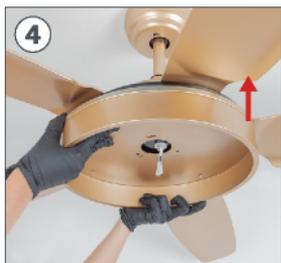
Placer la pièce **G** aligner ses trous avec les trous du moteur.
