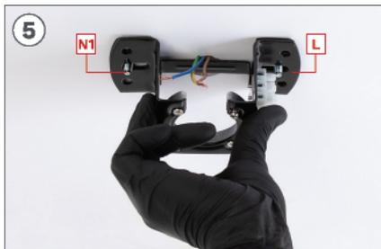
Placer la pièce **L** faire correspondre ses trous avec les vis **N1**. Assurez-vous que les câbles de plafond sont d'un côté de la pièce **L**.
