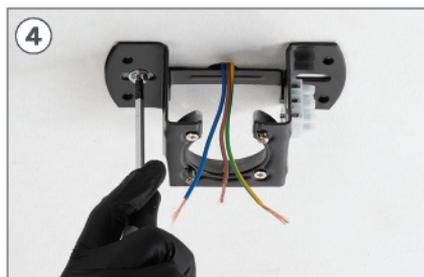
Placer la pièce L et vissez les vis de fixation sur le faux plafond.
