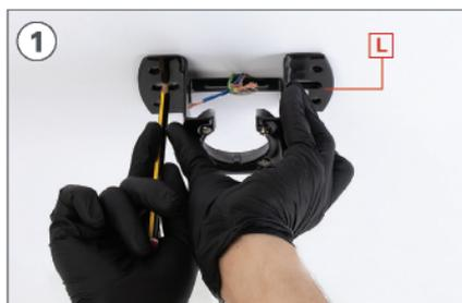
Marquer au plafond avec un crayon les 2 trous centraux de la pièce L en utilisant la pièce comme un guide.
