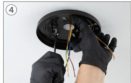
Placer la pièce A et visser les vis de fixation au faux plafond.
