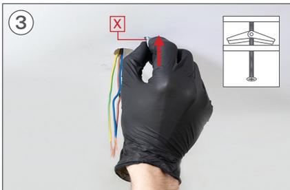
Insérez les vis de réglage dans les trous et assurez-vous que le levier s'ouvre.
