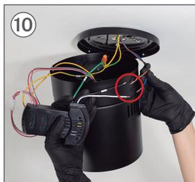
10 Connectez le câble NEUTRE du driver (AC-N) au câble NEUTRE de votre installation.
