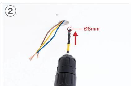
2 A l'aide d'une perceuse, réaliser les deux trous correspondants avec un foret Ø8 mm.
