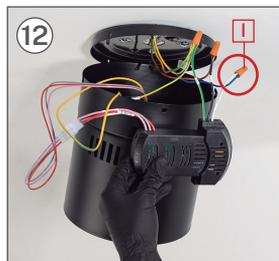
12 Connectez le câble PHASE du driver (AC-L) au câble PHASE de votre installation. Une fois connecté, placez la pièce I.
