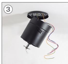
Insérez le crochet de pièce A dans un trou de la pièce I afin que le moteur soit suspendu et faciliter le raccordement des câbles.
