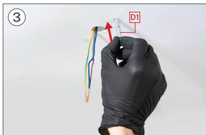
3 Insérer les morceaux D1 dans les trous du plafond.
