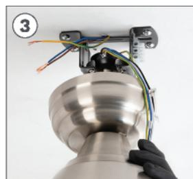
Placez le support d'inclinaison dans la fente de la pièce K de sorte qu'il soit fixé au plafond. N'oubliez pas de remettre l'encoche sur le haut noir pour que la pièce s'adapte bien.
