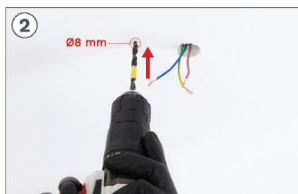
2 A l'aide d'un foret, réalisez les deux trous correspondants avec un foret de  $\varnothing 8$  mm.
