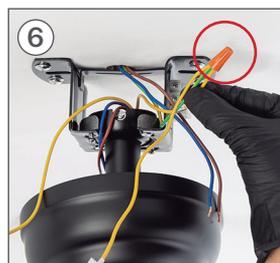
Connectez le fil de terre de la pièce H celle du moteur. De plus, si votre installation électrique est constituée de votre propre câble de mise à la terre, connectez-le également aux câbles de la pièce H et le moteur.
