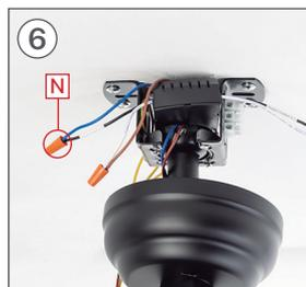
Connectez le fil PHASE (L) de votre installation au fil PHASE de la pièce **B**. Une fois connecté, placez la pièce **N** le visser jusqu'à ce qu'il soit bien fixé.
