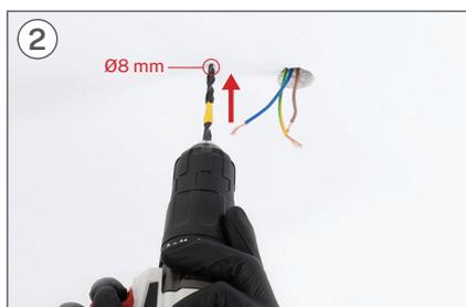
2 A l'aide d'un foret, réalisez les deux trous correspondants avec un foret de Ø8 mm.
