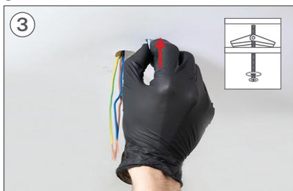
3 Insérez les vis de réglage dans les trous et assurez-vous que le levier s'ouvre.
