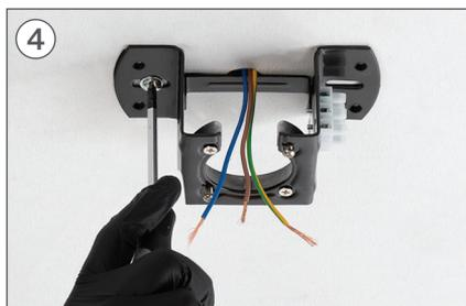
4 placer la pièce K et visser les vis de fixation au faux plafond.
