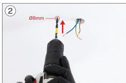
A l'aide d'une perceuse, réaliser les deux trous correspondants avec un foret Ø8 mm.
