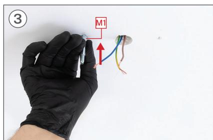
placer les morceaux **M1** dans les trous du plafond.
