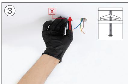
3 Insérez les vis de fixation dans les trous et assurez-vous que le levier s'ouvre.
