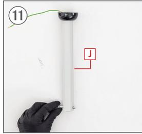
11 Serrez les deux vis sur le support d'inclinaison avec le tournevis.
