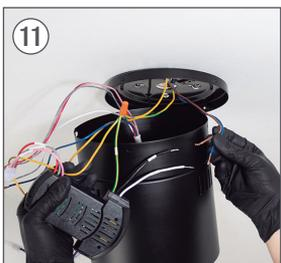
11 Conecte el cable FASE del driver (AC-L) al cable FASE de su instalación.
