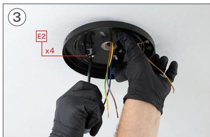
3 Coloque la arandela y posteriormente el tornillo D2 con la ayuda del destornillador.
