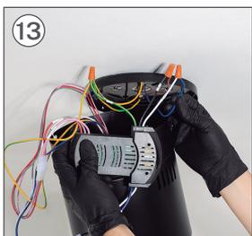
13 Conecte el cable NEUTRO del driver (AC-N) al cable NEUTRO de su instalación. Una vez conectados, coloque la pieza **M**.
