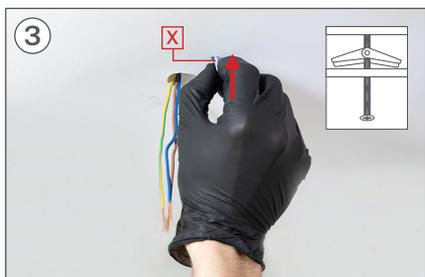
Introduzca los tornillos de fijación en los agujeros y asegúrese de que la palanca se abre.
