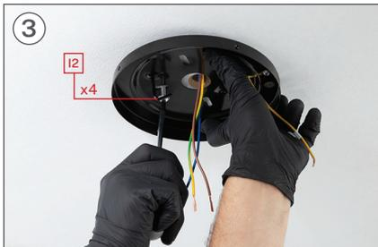
Coloque la arandela y posteriormente el tornillo I2 con la ayuda del destornillador.
