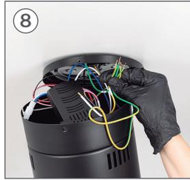
Seleccione y conecte todos los cables de toma de tierra, incluyendo el de su instalación.
