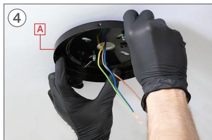
Coloque la pieza H haciendo coincidir sus agujeros con los tornillos I. Asegúrese de que los cables del techo pasan por el agujero central de la pieza H.
