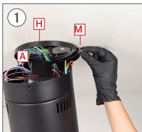
Utilice 2 tornillos M y enrésquelos, sin apretarlos demasiado, en los agujeros paralelos de la pieza H.
