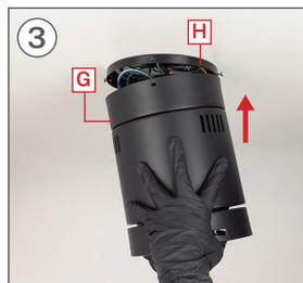
Saque la pieza G del gancho y encájela en la pieza H sin pellizcar ningún cable.
