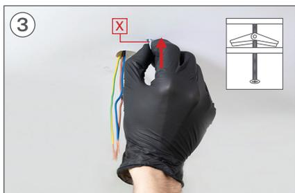
3 Introduzca los tornillos de fijación en los agujeros y asegúrese de que la palanca se abre.
