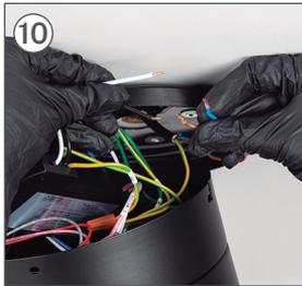
Conecte el cable NEUTRO (N) del driver al cable NEUTRO de su instalación.
