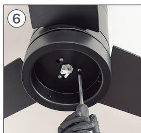
Deje los cables azul y blanco saliendo por el agujero, después apriete con fuerza los tornillos usados en el paso 1 de manera que la pieza F quede correctamente sujeta.
