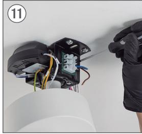
11 Conecte el cable N del driver al cable NEUTRO de su instalación.
