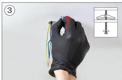
Introduzca los tornillos de fijación en los agujeros y asegúrese de que la palanca se abra.
