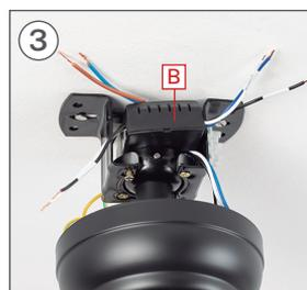
Inserte la pieza **B** en la ranura de la pieza **K**. Compruebe que todos los cables están correctamente colocados sin quedar atrapados.
