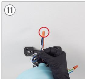
Conecte el cable Fase (F) con el cable negro (motor) y el cable azul (lámpara). Una vez conectados, coloque la pieza M enroscándola hasta que quede bien sujeta.
