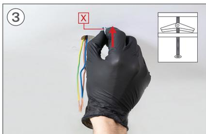
Introduzca los tornillos de fijación en los agujeros y asegúrese de que la palanca se abre.
