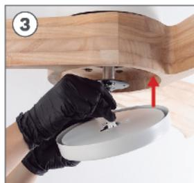
Pase los cables del motor por el agujero central de la pieza N.
