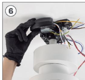
Una vez conectados los cables, introduzca la pieza **B** dentro de la pieza **K**, como se muestra en la imagen.
