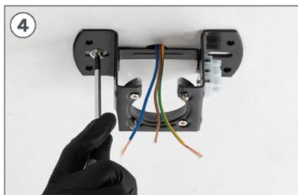
4 Coloque la pieza K y atornille los tornillos de fijación al falso techo.
