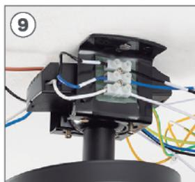
Con la ayuda de un destornillador plano, conecte los cables restantes de la pieza **B** a los del ventilador, uniendo cada uno con la regleta y su respectivo cable.
