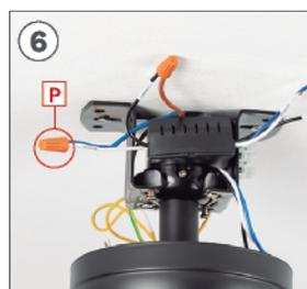
Conecte el cable FASE (L) de su instalación al cable FASE de la pieza **B**. Una vez conectados, coloque la pieza **P** enroscándola hasta que quede bien sujeta.
