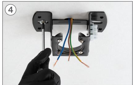
4 Coloque la pieza K y atornille los tornillos de fijación al falso techo.
