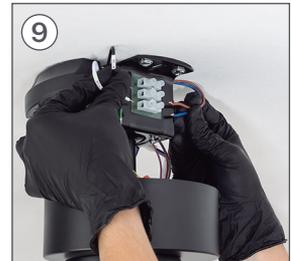
Deberá unir los cables restantes de la pieza B y los cables fase y neutro de su instalación en la regleta de la pieza K, como se muestra a continuación.
