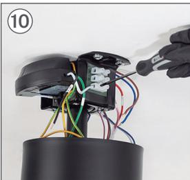
Conecte el cable L del driver al cable FASE de su instalación.
