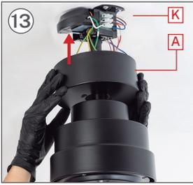
Deslice la pieza A hacia arriba para encajarla en los tornillos que sobresalen de la pieza K.
