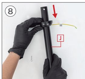
Coloque el soporte de inclinación en la barra J.
