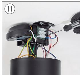
Conecte el cable N del driver al cable NEUTRO de su instalación.
