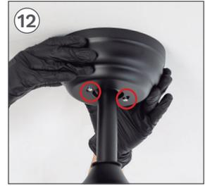
Una vez conectados los cables, deslice la pieza **A** hacia arriba para encajarla en los tornillos que sobresalen de la pieza **J**. Una vez encajados, gire la pieza **A** hacia la derecha.
