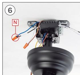
Conecte el cable FASE (L) de su instalación al cable FASE de la pieza **B**. Una vez conectados, coloque la pieza **N** enroscándola hasta que quede bien sujeta.
