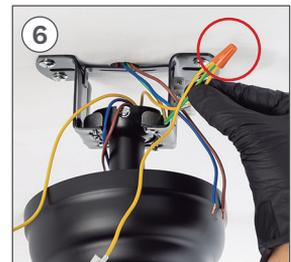
Conecte el cable de la toma de tierra de la pieza **H** al del motor. Además, si su instalación eléctrica consta de cable de toma de tierra propio, conéctelo también a los cables de la pieza **H** y el motor.
